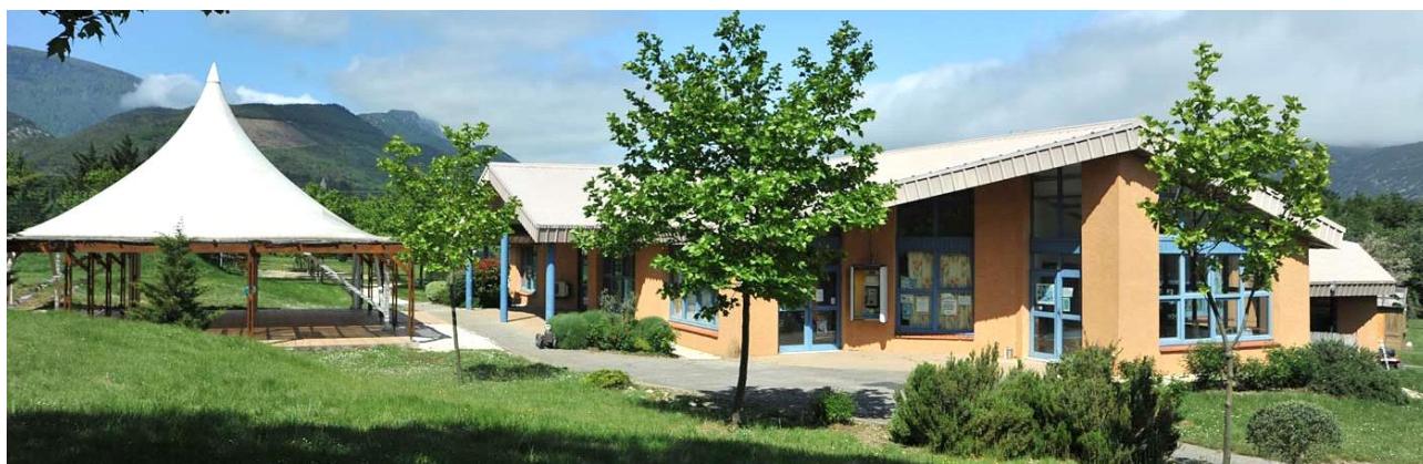
Photo 3 : Bâtiment principal du camping - centre de pleine nature
