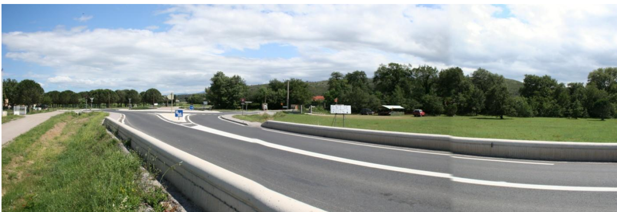
Vue 1 sur les infrastructures routière après le pont sur la rivière du "Castelnou", coté Castelnou et sur une partie du secteur (sur la droite.)
