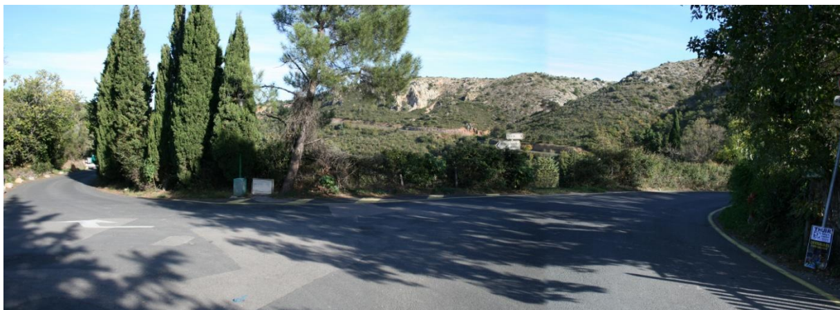
Vue sur le point ou espace de raccordement n°2 à la D48
