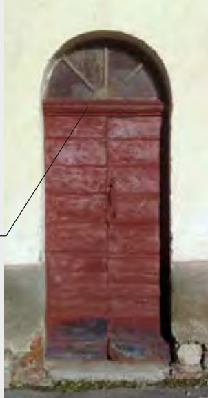
Porte en bois, à planche horizontale jointive en extérieur. Imposte fixe vitrée. Arc plein cintre.
