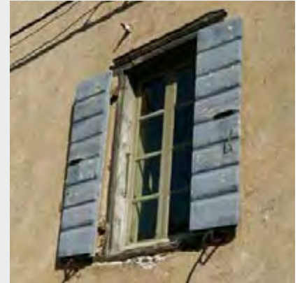
Sahorre - Contour et linteau en bois, contrevent à double cours de planches croisées.
