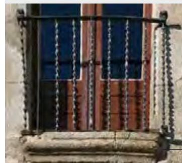
Dorres - Garde-corps en fer forgé. Le barreaudage torsadé est très répandu en Catalogne.
