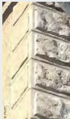
Décor en stuc d'une chaîne d'angle imitation pierre avec la technique du bosselage.
