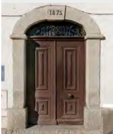
Bourg-Madame - Arc en anse de panier à cinq claveaux en pierre de taille - Millésime de construction «1875» gravé sur la clef.
