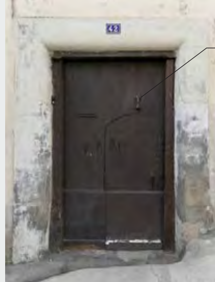
Porte « tiercée » constituée de planches verticales consolidées par un parquet (planches horizontales) en partie inférieure et de deux vantaux de taille différente s'ouvrant selon leur usage.
