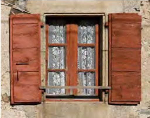
Villeneuve-de-Formigüeres - Encadrement à feuillure* en pierre de taille. Contrevent à planches horizontales jointives en face interne. Fenêtre à petit-bois.
