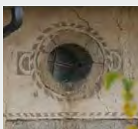
Latour-de-Carol - Sgraffite autour d'un œil-de-bœuf au dernier étage
