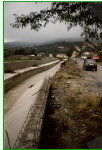
Tête du canal de dérivation du Val Pompo (à gauche) et digue rive droite du canal de dérivation à hauteur du Pla de la Rethorie emportée avant l'achèvement des travaux (à droite) lors de la crue d'octobre 1987.
