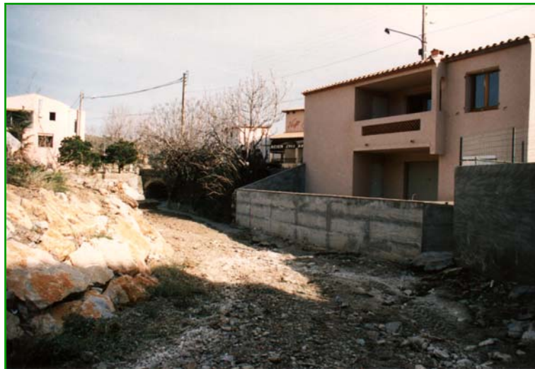
Bâtiment construit dans le lit du Coma-Pascole
