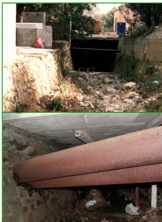
Conduites en travers du canal souterrain du ravin d'Armen, au droit du Centre Héli- marin
