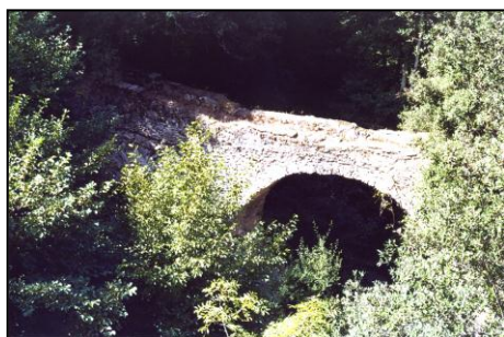
Pont visible de la route qui mène à Montalba
