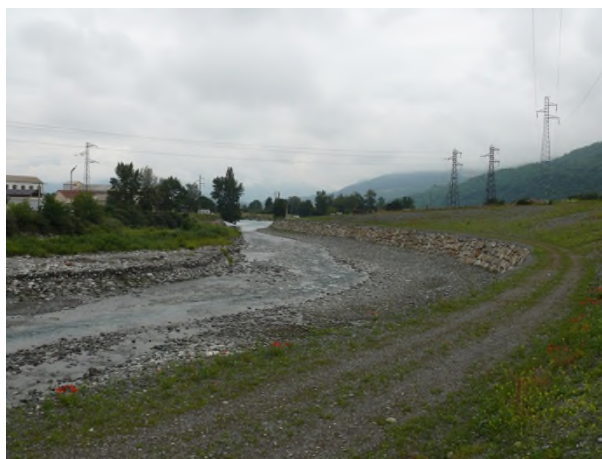
Absence de ripisylve, berges terrassées et enrochements aux abords du Gave de Pau en limite Ouest de la commune (photo ARTELIA)
