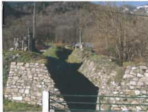
Ruisseau de la Praderasse en bordure de la RD 25
