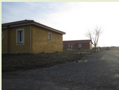
Constructions neuves : quartier de Montjoye
