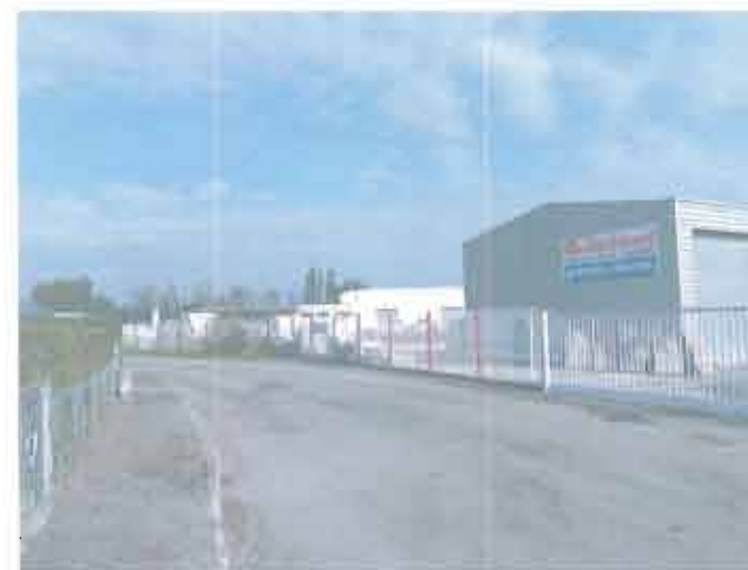
Lotissement industriel à Renson
