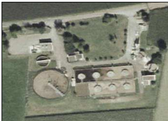
Figure 8-2 : Vue aérienne de la station de Tarbes Ouest
