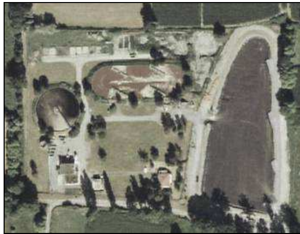
Figure 8-1 : Vue aérienne de la station de Tarbes Ouest
