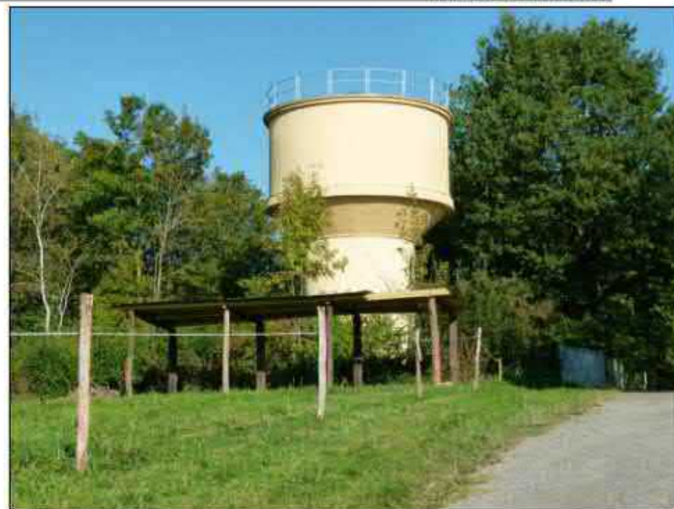
Château d'eau de Séméac
