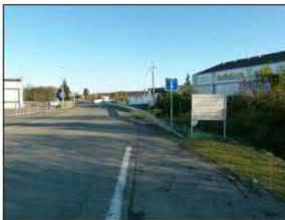
Voirie desservant la zone artisanale de Lasgarrenes
