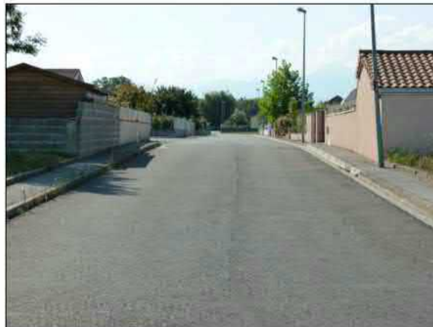
Exemple de profil de voirie ne favorisant pas l'utilisation des modes doux – Rue du Général Pottier
