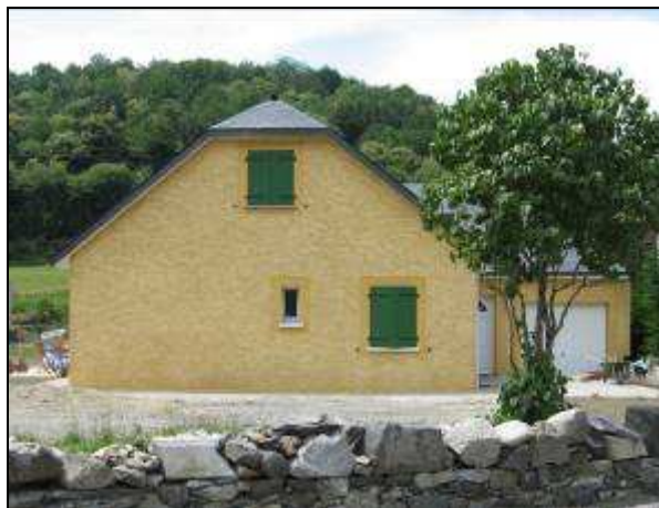
Quart de croupe traditionnel et ardoises associés à une teinte de façade « plus actuelle »
