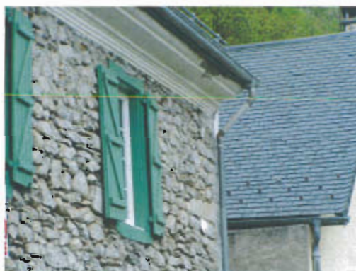
Encorbellement en moulure
