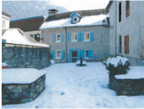
L'espace public structuré par le bâti
