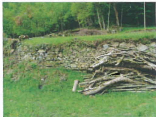
Prairies étagées entre le canal et la zone boisée
