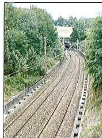
La voie ferrée
