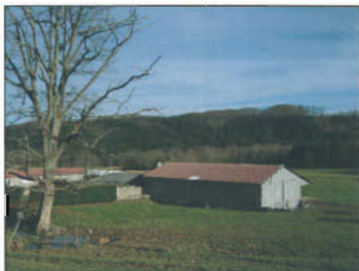
Bâtiment agricole à Réjaumont
