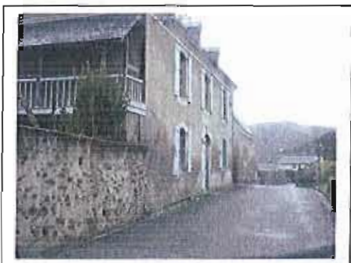
Le bitume occupe toute la voie
