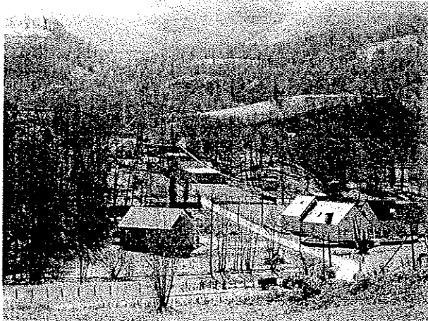
Constructions récentes de Lonca et Turon. Le ruisseau du Riu Long s'écoule en fond de talweg
