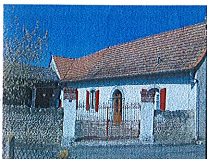
Mur maçonné en limite séparative sur rue
