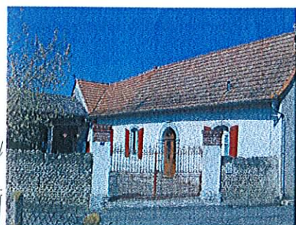
Mur maçonné en limite séparative sur rue
