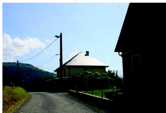
Les bâtiments ont régulièrement une hauteur de RDC + Combles
