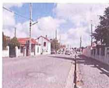
RD 939 en section urbaine
