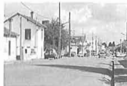
La Rue du 8 mai 1945, dans le prolongement de la RD 939, présente un aspect uniquement routier, qui ne marque pas favorablement l'entrée de ville
