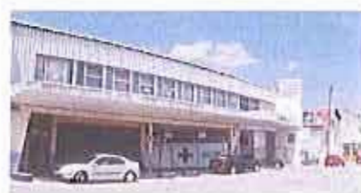
Garage automobile délabré, rue Clemenceau
