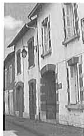
Encadrement des ouvertures en briques.
