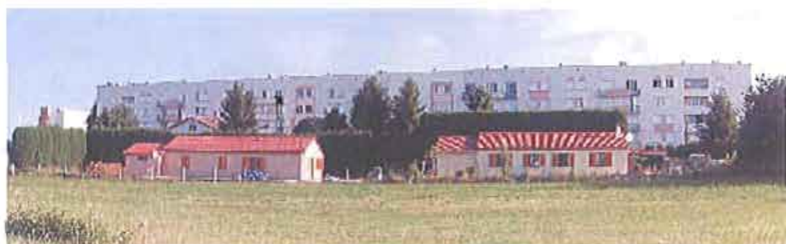
Résidence du Pic du Midi : contraste brutal entre le pavillonnaire de plain-pied, et les volumes importants de la barre
