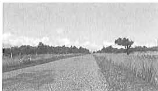
Manque d'aménagement de la voie de desserte principale : la RD 717
