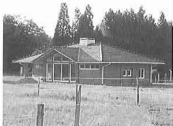
Nouvelle construction en bois
