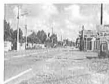
La RD 939, d'aspect routier, est bordée de bâtiments d'artisanat et d'habitations hétéroclites
