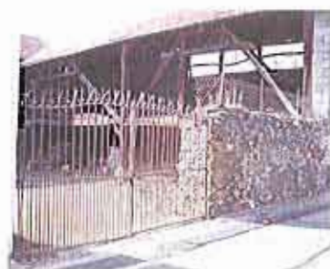
Des ferronneries agrémentent les bords de la ferme, pour les portails.
