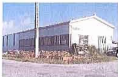
Menuiserie avec stockages en façade, ZI Peyrehitte
