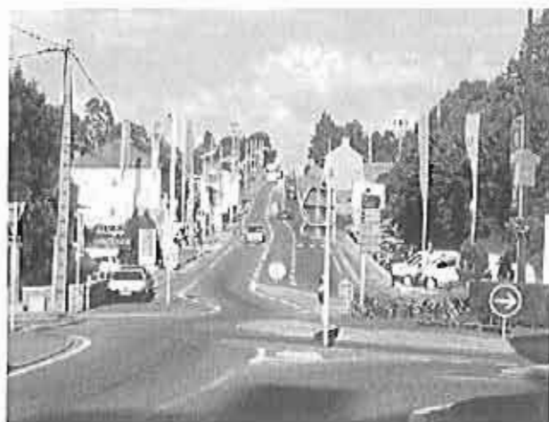
RD 817 en entrée d'agglomération : les activités se sont implantées de part et d'autres
