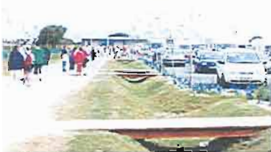
articulation entre chemin piéton et aire de stationnement par ponceaux en bois au-dessus d'un fossé (Normandie)
