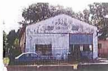
Bâtiment d'artisanat délabré, rue des Résistants
