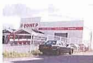
Bâtiment commercial rue des Résistants
