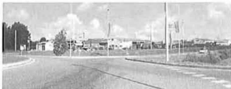
A la sortie de l'échangeur, les bâtiments d'artisanat présentent un aspect architectural hétéroclite
