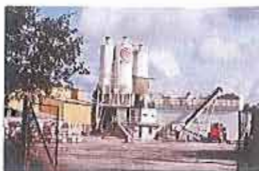
Tour à béton en entrée de ville Sud
