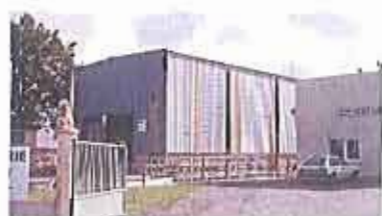
Bâtiment d'artisanat en tôle, peu intégré, rue des Résistants
