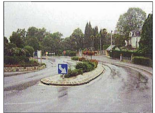
La RD 95, axe structurant de Julos
