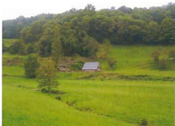
Grange rénovée avec un toit en tôle
