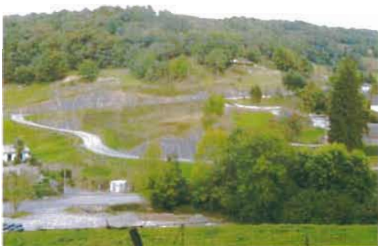
La déviation de la RD 97 située à l'est du village de Jarret
