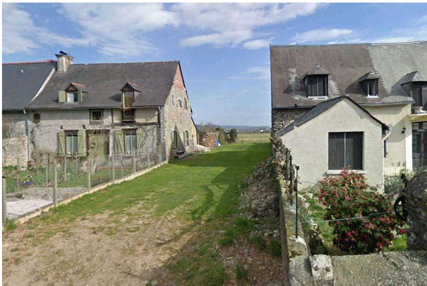
Vue sur la future voie d'accès entre la rue du 8 mai et le quartier de Darré Sualet
