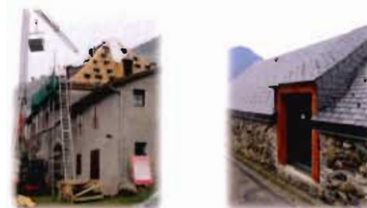
Intervention en cours sur le bâti dans le village. Traitement récent des ouvertures et de la toiture dans le cadre de la reconversion d'une ancienne grange en habitation.
