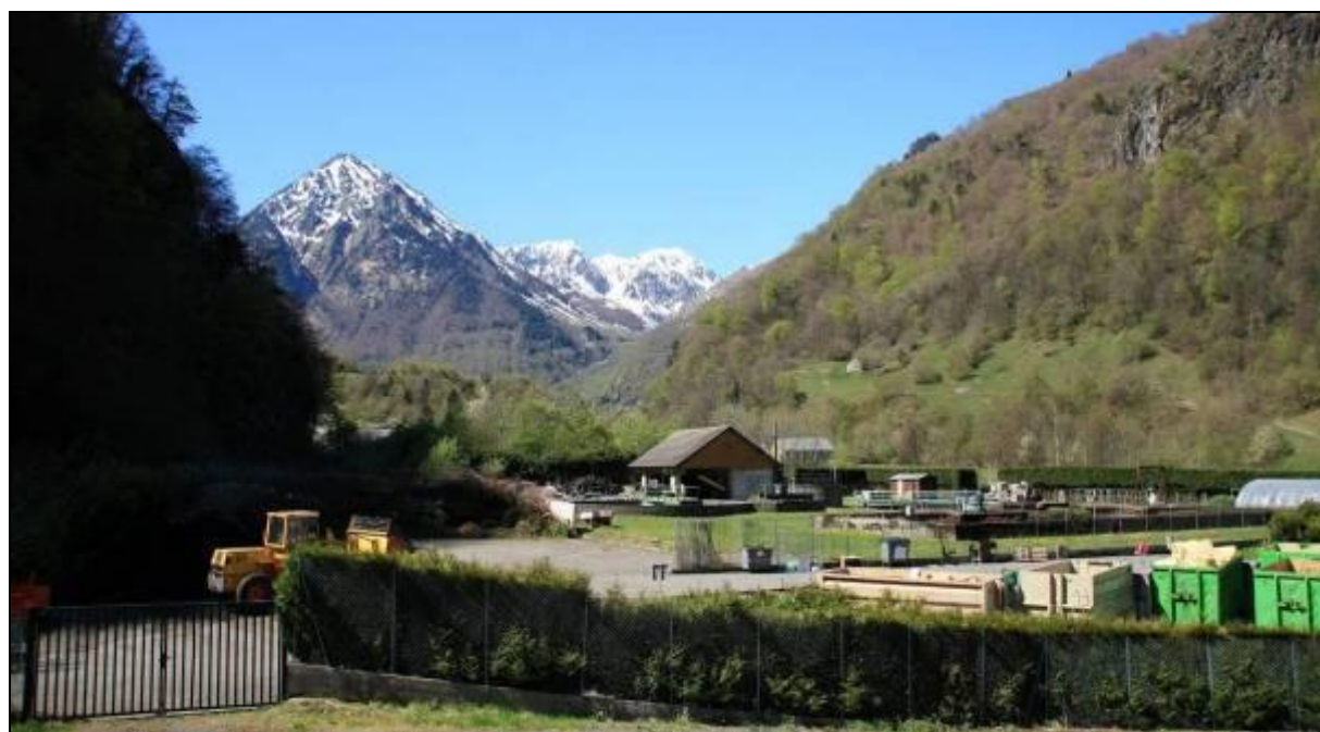
Vue sur la déchetterie Calypso à Cauterets, le Péguyère en arrière plan © ETEN Environnement
