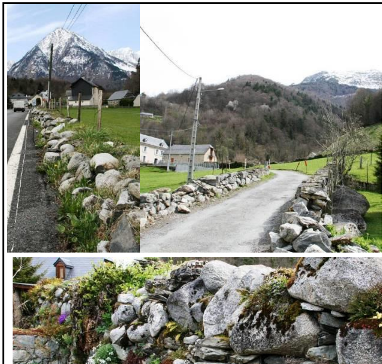
Murs de pierre rencontrés à Cauterets © ETEN Environnement
