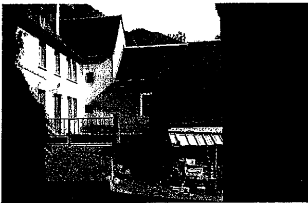
Bâti dans la partie amont
