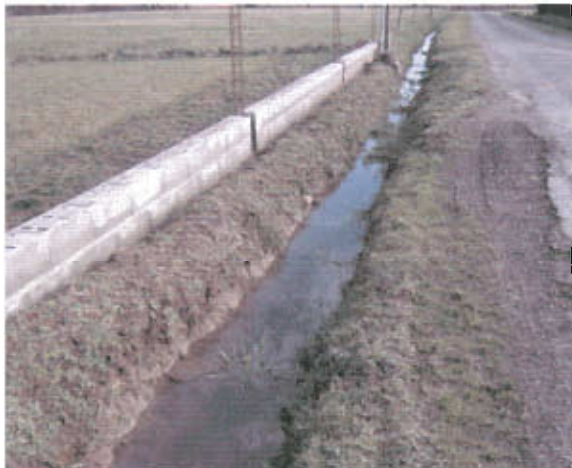
L'un des fossés à faible écoulement hydraulique le long du chemin de Villenave
