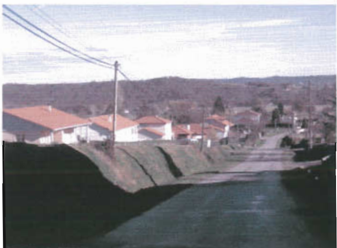
Perception linéaire des nouvelles habitations le long du cami de la Hountasse
