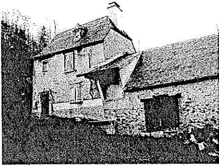
Bâti ancien à réhabiliter
