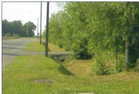
Figure 5 – Exemples de noues de stockage/infiltration des eaux pluviales
