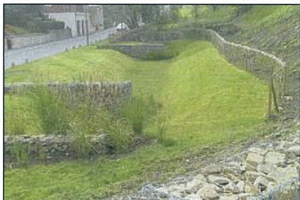
Figure 5 – Exemples de noues de stockage/infiltration des eaux pluviales
