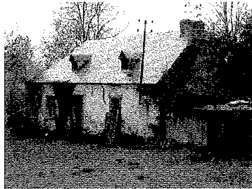
Bâti en cours de restauration
