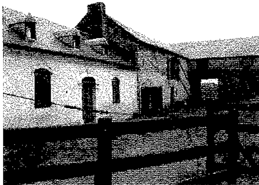
Corps de ferme à Avezac
