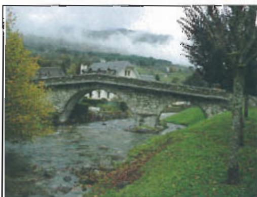
Aménagement de canaux dans le centre d'Arrens
