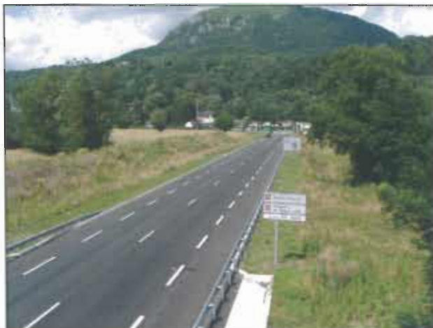
Photo 3 : Rupture physique entre chaque côté de la séquence
