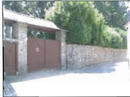
Mur en pierres ceinturant le parc du château
