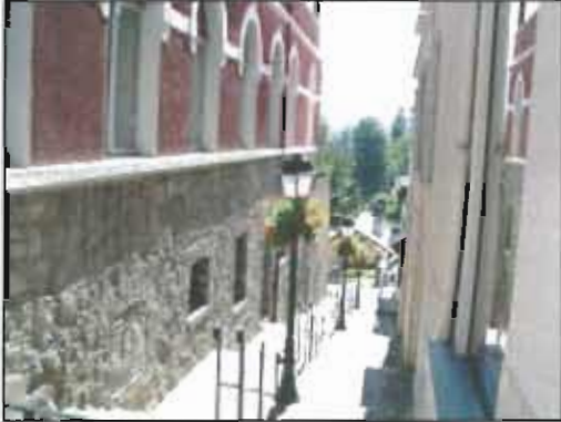
Passage du Parc : Passage piéton ville haute/ville basse
