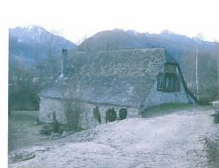
Granges de rues réhabilitées en habitation
