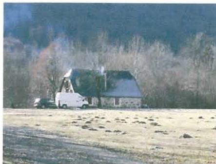
Grange réhabilitée dans le bocage de Bergons
