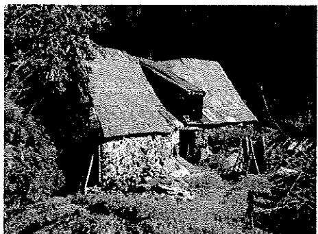
grange foraine vacante à réhabiliter
