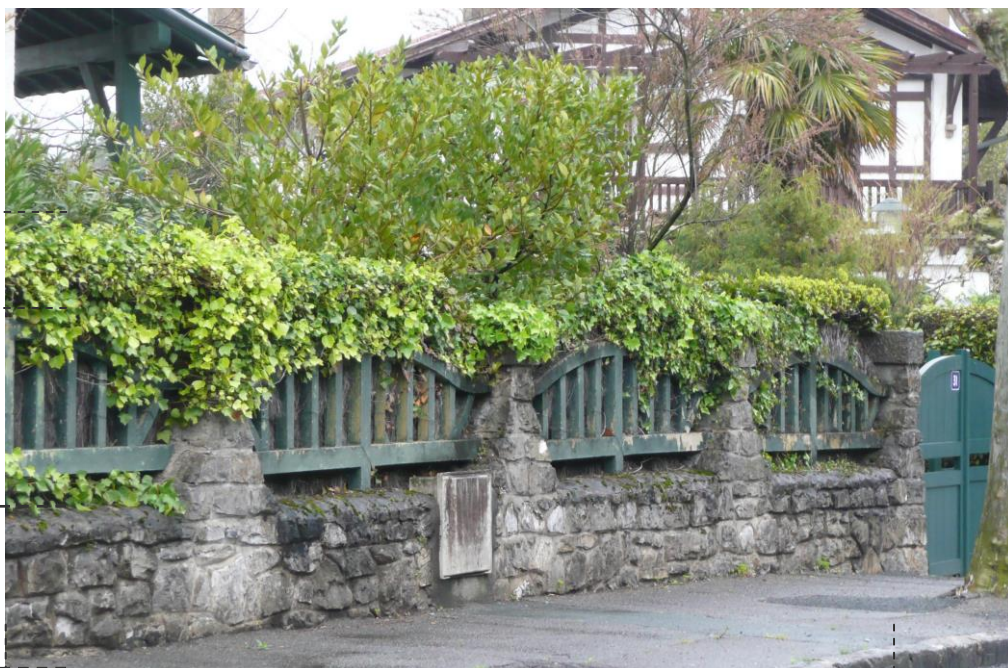
La partie courante de la clôture
