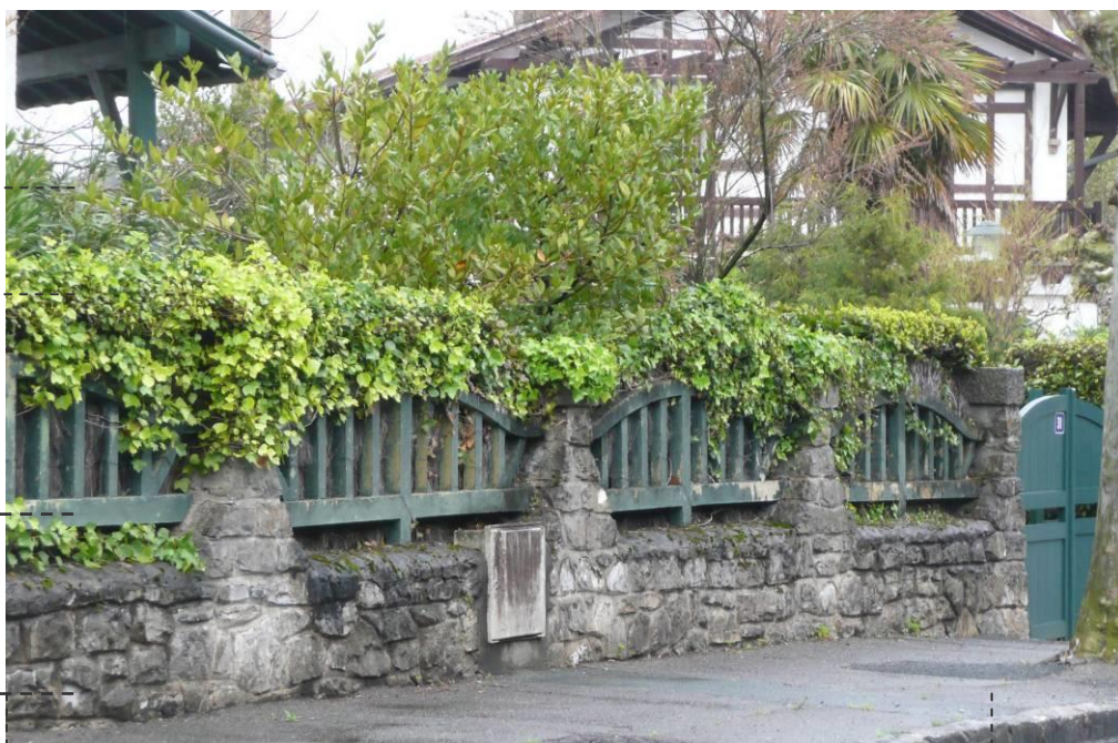
La partie courante de la clôture
