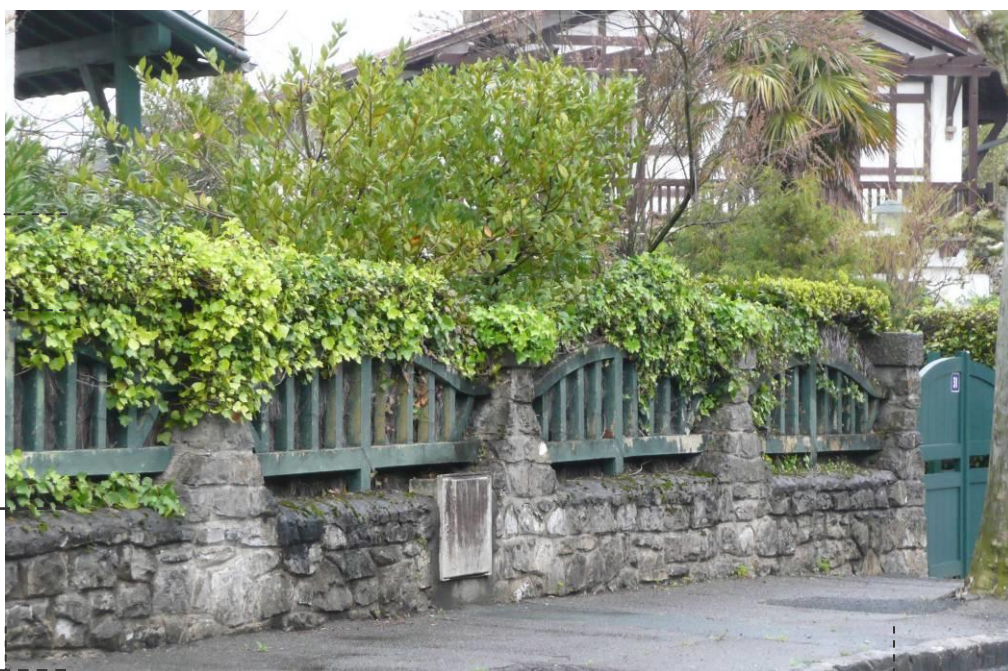
La partie courante de la clôture
