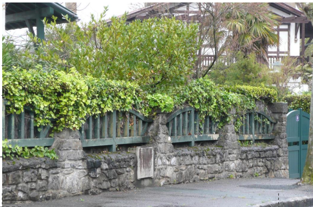
La partie courante de la clôture
