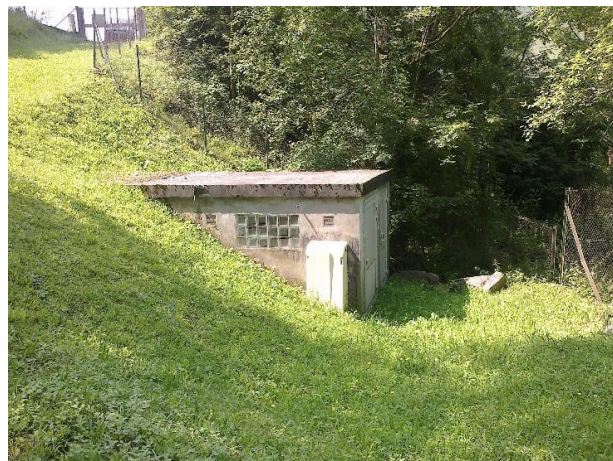
Captage de Miédougé
