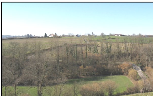
Pont de la D246 enjambant le ruisseau Minhurieta
