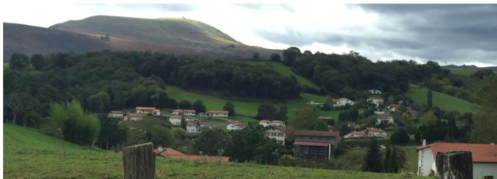
Implantation du bâti sur les versants – Quartier Fagaldea
