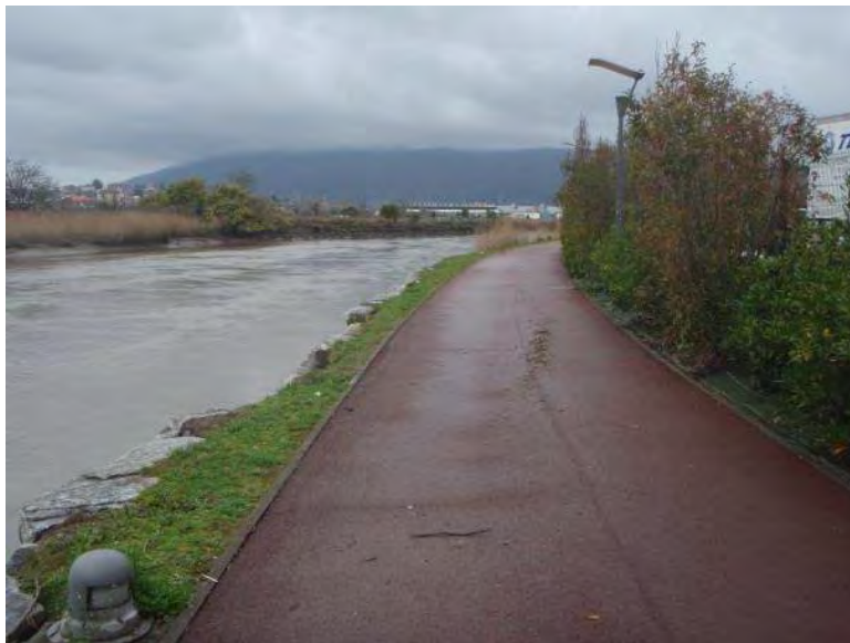
Figure 27 : Promenade des Joncaux considérée comme digue sur ce tronçon.
