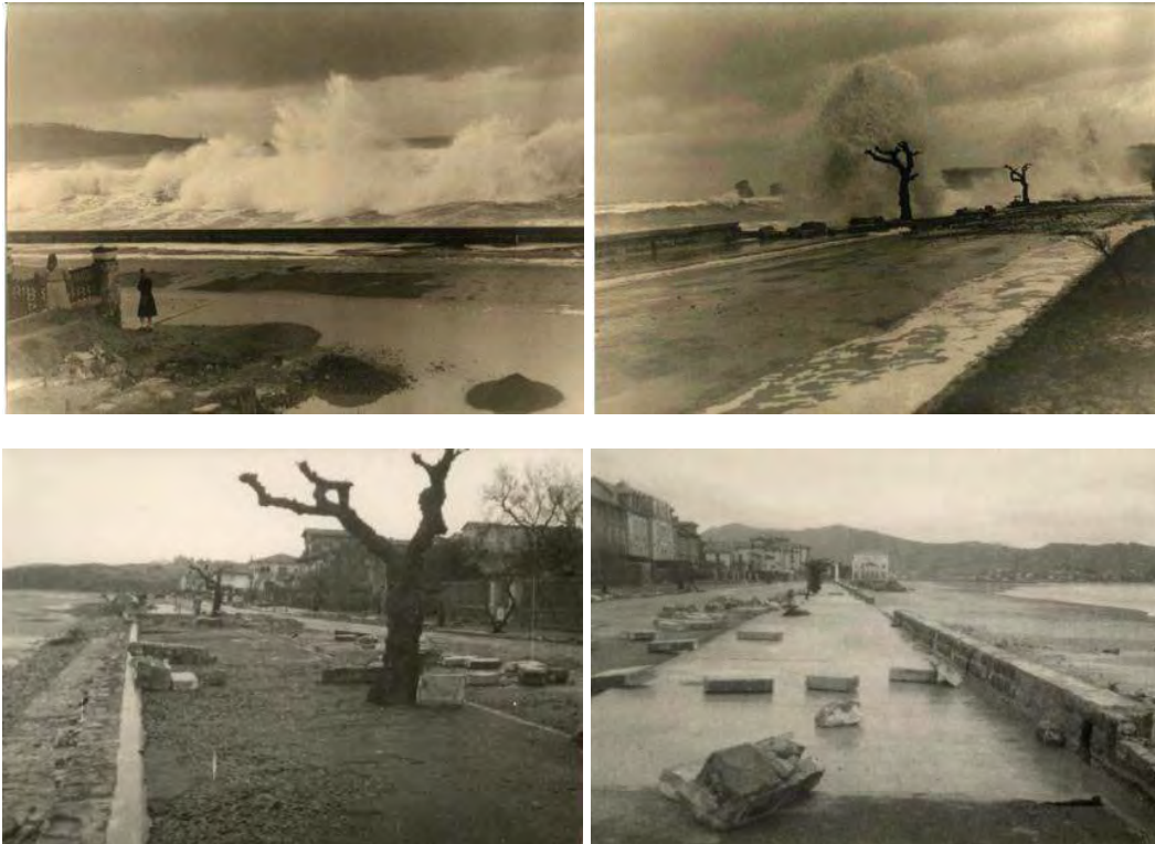
Figure 21 : Tempête de 1951, type de submersion observable et illustration des dégâts occasionnés sur le perré.
