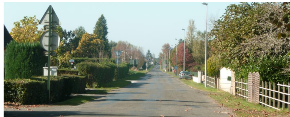
Vue sur l'urbanisation linéaire de part et d'autre de la RD 836. Source : APGL
