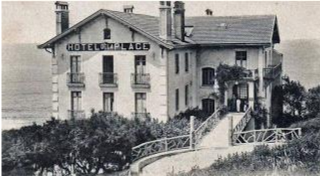
La passerelle de l'ancien hôtel de la plage, fonction maintenue par l'architecture d'Itsasoan http://www.paysbasque1900.com
