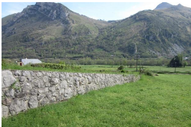
Mur de soutènement entre le terrain et la voie
