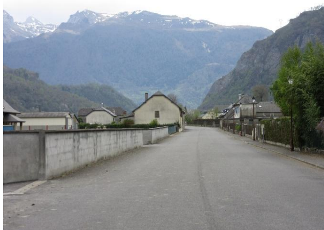
Vue sur la RD2934
