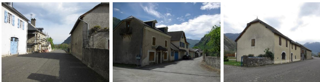
Bâti ancien au nord de Bélesten , quartier Monplaisir et quartier de la mairie. Source : APGL64
