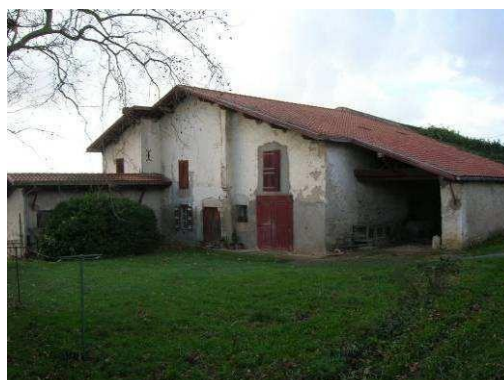
Vue sur la façade est de la ferme
