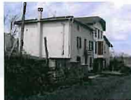
Lorille, toiture terrasse et toiture à pans coupés
