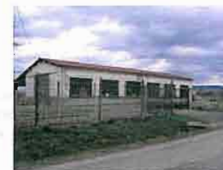
Menuiserie le long de la RD 7
