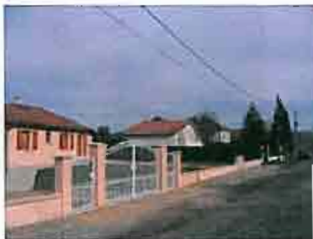
Les Plaines, hétérogénéité du bâti et des limites de propriétés
