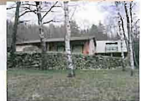
Chossière, matériaux et couleurs qui s'intègrent difficilement
