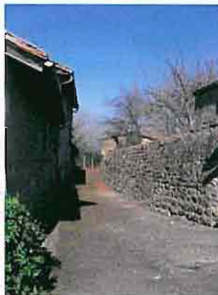
Mur d'enceinte autour du centre ancien
