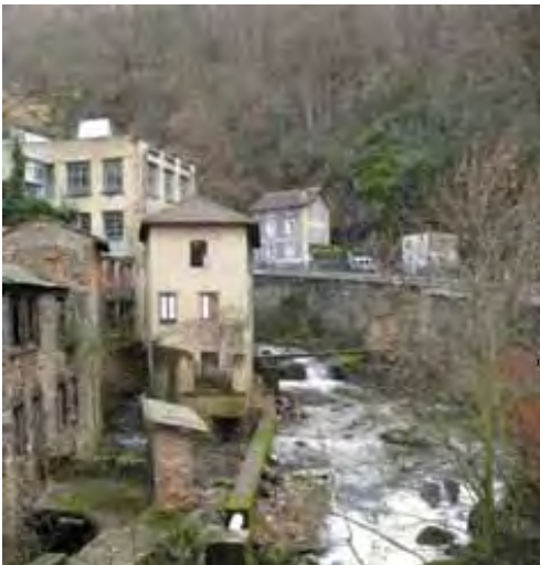
Photo 8 : secteur de gorge (source BCEOM)
