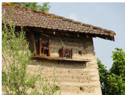
Les pigeonniers caisses, dit également fuies, installés sous les toitures, accrochés aux façades.
