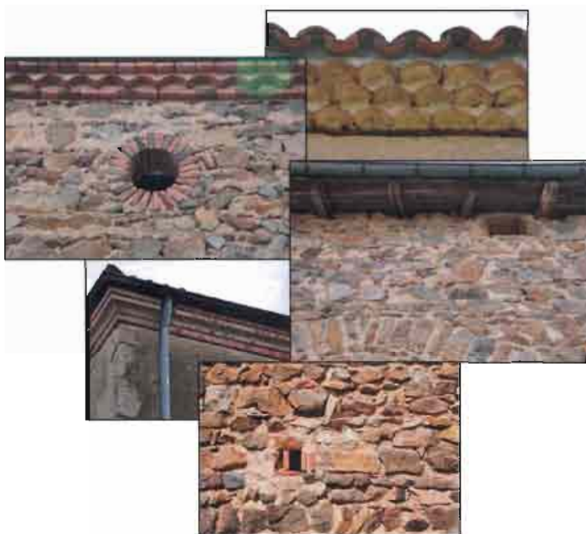
Murs en moellons de pierres locales, débord du toit soutenu par une génoise, une corniche en briques ou un simple débord des chevrons
