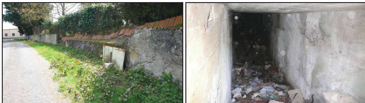
Tête de descenderie bétonnée partiellement ouverte, La Vernade
