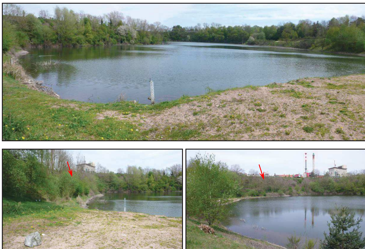
Tranchée Roland. Zone de glissements superficiels de remblais
