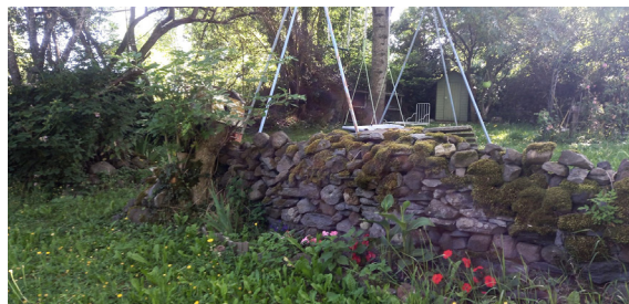
A Olmont, clôture ancienne : mur en pierre sèche
