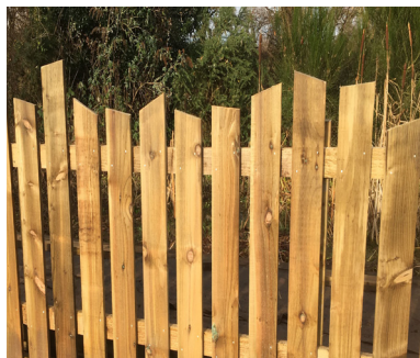
Palissade en bois
