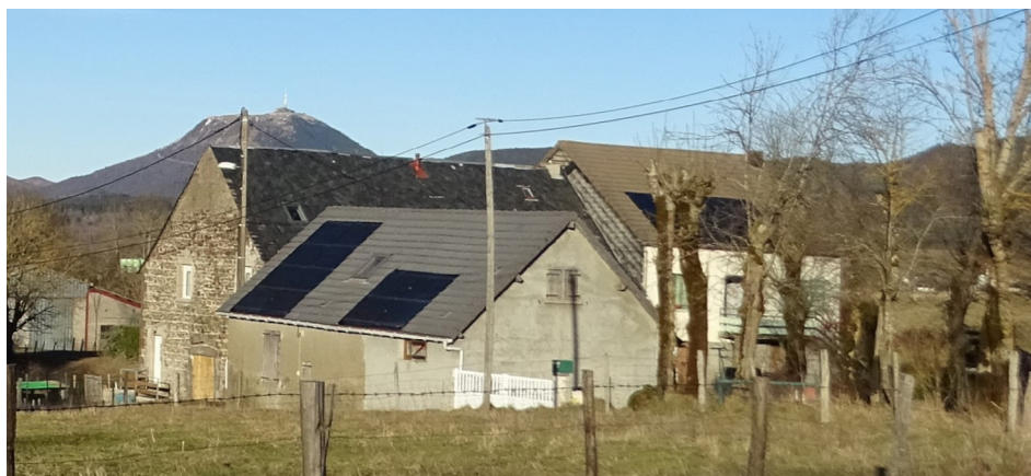
A Olmont, exemples de structures d'encadrement de même couleur que les panneaux solaires
