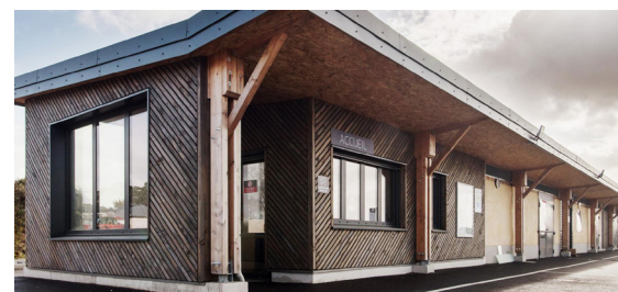
Travail sur les matériaux pour cette déchetterie : bois et enduit terre (Liffré, 35)
