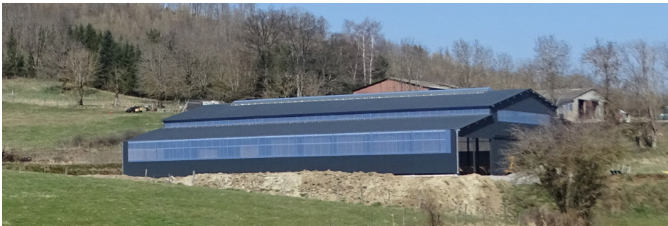
A Juegheat, au-delà de son implantation imposante et des terrassements conséquents pour ce bâtiment, l'agencement régulier des ouvertures est harmonieux. Un accompagnement végétal est attendu pour filtrer les vues lointaines.
