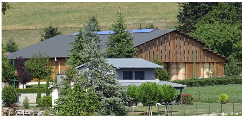
Exemple de bâtiment de qualité : déchocqué de toiture, soin des ouvertures et des lignes des façades (15)
