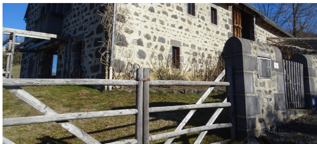
A Polagnat, clôture très qualitative : mur en pierre de pays, portail et portillon rustiques en bois grisant
